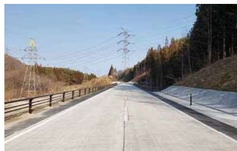
コンクリート舗装 （小野富岡線 小白井工区 いわき市）
