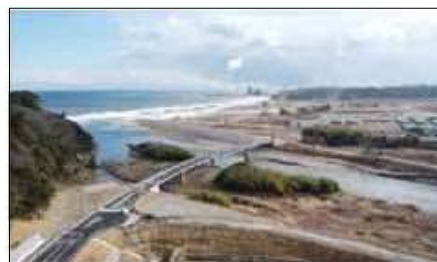
広野小高線 天神工区（檜葉町）
