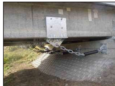
対策実施済の橋梁 (塙大津港線 塙町)
