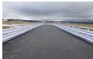
H31.3.29仮橋供用開始
