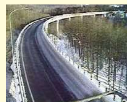
国道115号 土湯峠 (横向大橋)
