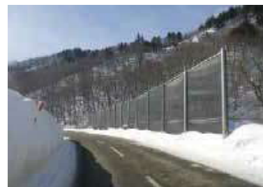
雪崩対策施設設置 (国道352号 南会津町)
