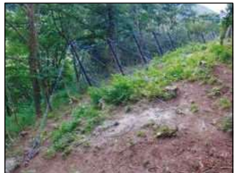
落石防護柵施工箇所 （国道118号 羽鳥工区 天栄村）
