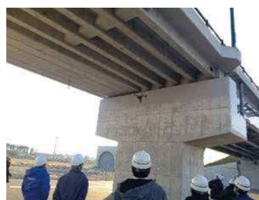
点検支援技術講習会の状況
