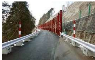
H23.12.22応急復旧完了 (通行止め解除)
