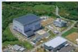
檜葉遠隔技術開発センター
