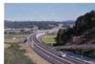
福島空港道路
