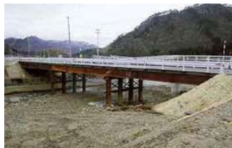
H23.11.11応急復旧完了 (通行止め解除)
