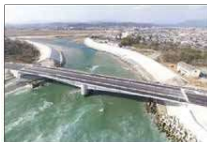
豊間四倉線 東舞子橋工区（いわき市）
