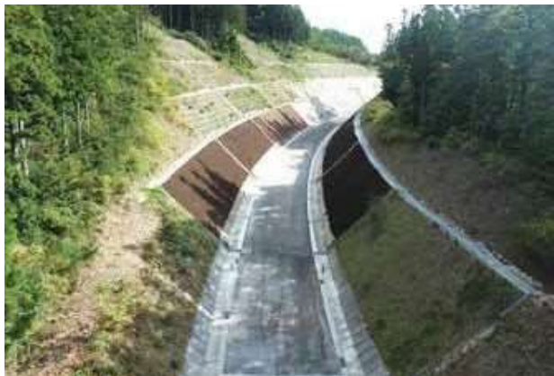
地域連携道路 (国道349号 檜坂工区)
