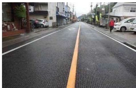
アスファルト舗装【20年設計】 （国道118号 矢祭町）
