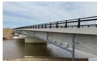
R2.12.25新橋供用
