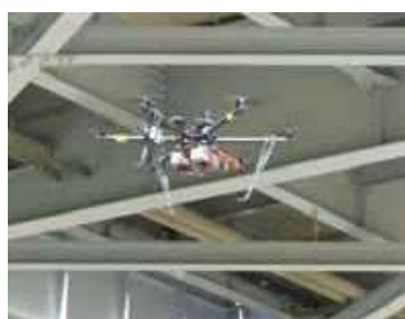
ドローンによる橋梁点検
