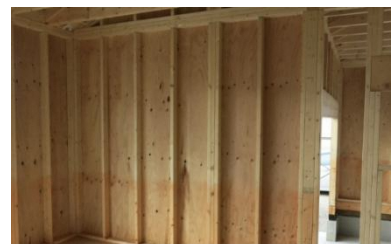
枠組壁工法 (ツーバイフォー工法)
