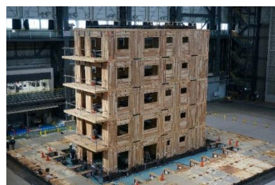
CLT パネル工法
