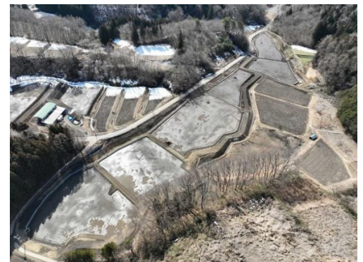
【北移地区工事完了の様子】
