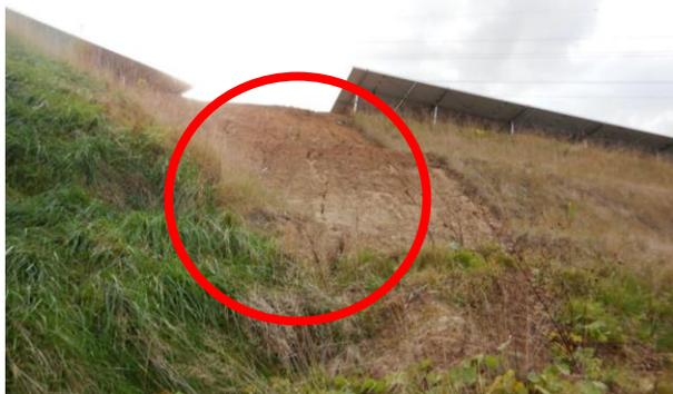
施工不備により土砂流出
