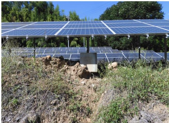
盛土が大きく崩落した太陽光発電設備
