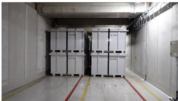
(写真 2 - 4) 貯蔵庫棟内の状況④ (地下 2 階の貯蔵レーンでの保管状況の例)
