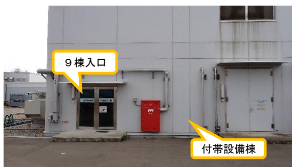
(写真 1) 固体廃棄物貯蔵庫第 9 棟の外観
