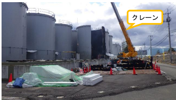
(写真 4 - 1) J 9 タンクエリア解体現場の状況
