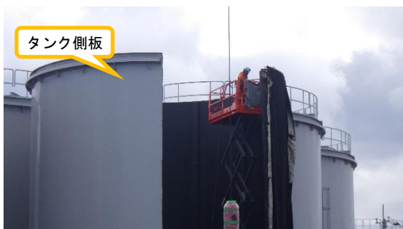
(写真 4 - 2) タンク側板解体作業の状況
