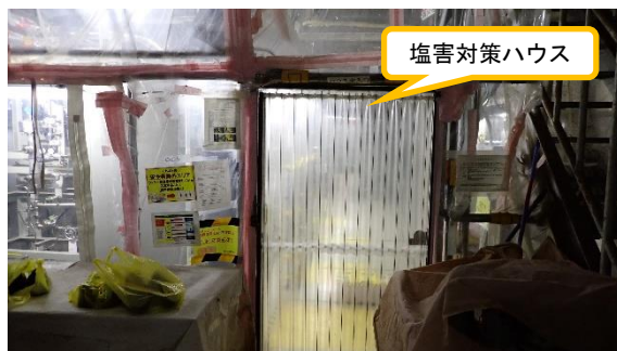
(写真1－1) 塩害対策ハウスの設置状況
