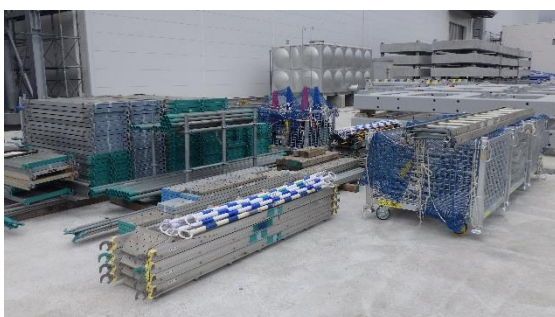
(写真4-5) 資機材の設置状況
