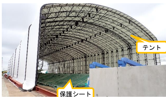
(写真1-1) 第4槽の状況① (北西側から撮影)
