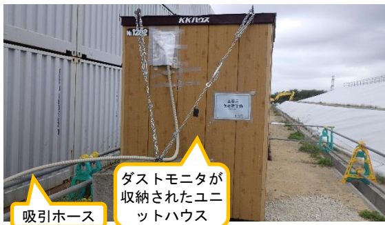
(写真 2－1) ダストモニタの設置状況 (北側から撮影)
