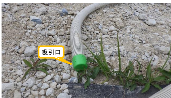
(写真 2－2) 吸引口設置状況
