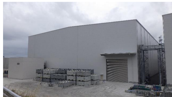
(写真4-2) 第10-C棟の外観② (北西側から撮影) (令和7年5月2日撮影)
