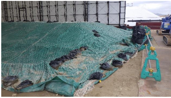
(写真 1－2) 第 4 槽の状況② (北西側から撮影)
