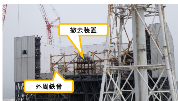
(写真4) 原子炉建屋外周の鉄骨の状況 ※写真左が北側
