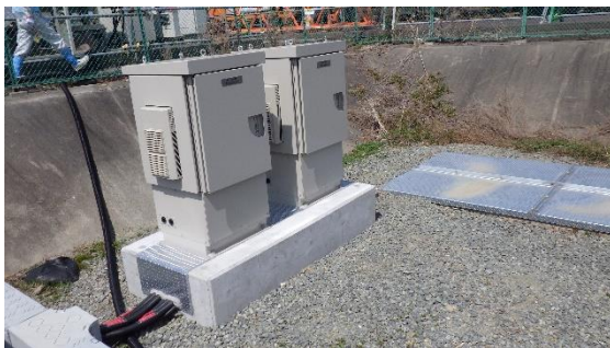
(写真 4－2) 新設されたP S Fモニタの状況② （データの収集は2系列）
