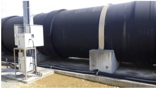
(写真 3－1) B C排水路（海側）の状況
