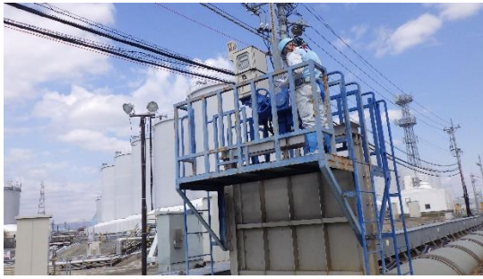
(写真 1－3) B－1 電動開閉ゲートの状況 (全開)
