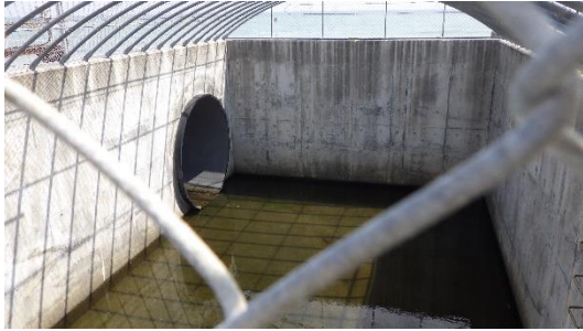
(写真 3－2) B C排水路（海側）直前に設置されている排水柵の状況
