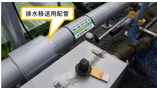
(写真 2－3) 電動開閉ゲート (B C－1) に設置 されている排水移送用配管の状況
