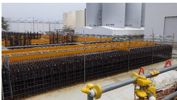
(写真1①) 配筋の状況
