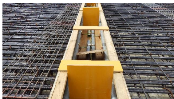
(写真1②) 型枠の設置状況
