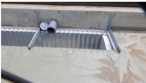
(写真3①)側溝の状況(西側)
