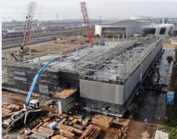
ポンプ車を使用し3階にコンクリートを打設しています。（R7.4月）
