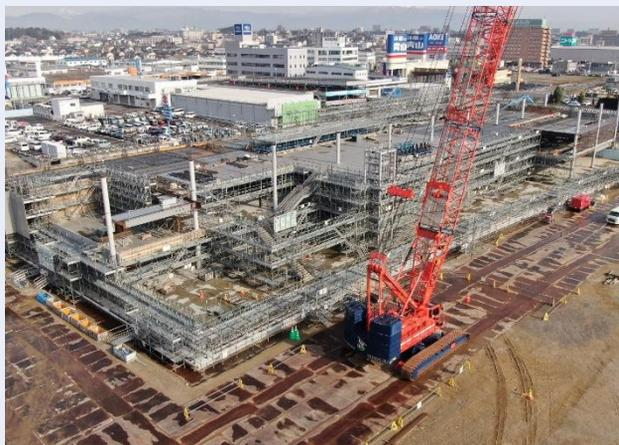
屋根を支える鉄骨の柱が立ち、3階床部分まで鉄骨工事が進みました。（R7.4月）
