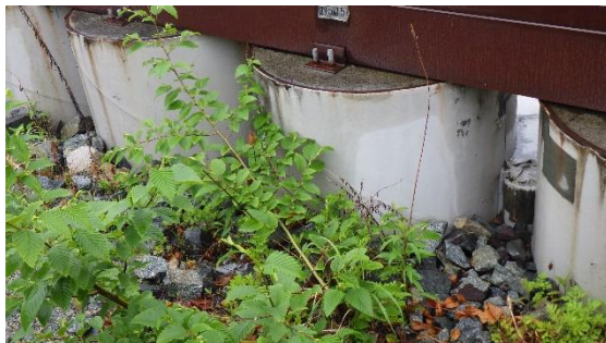
(写真2) 鋼管矢板上部
