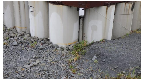
(写真1②) 海側遮水壁最北端コーナー部
