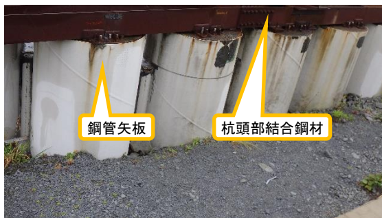
(写真1①) 海側遮水壁の状況
