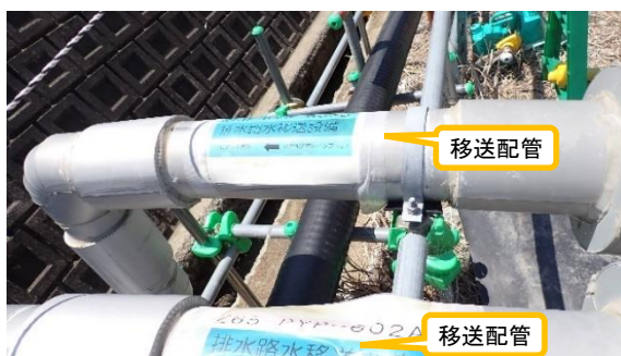
(写真 2 - 2) 移送配管の設置状況 (プロセス主建屋への移送)
