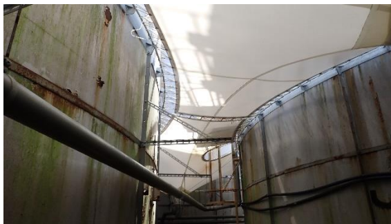
(写真 6) 堰カバー、雨樋の状況
