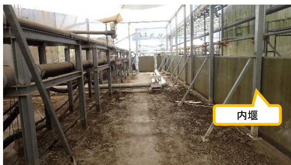
(写真 3 - 2) 内堰内の状況
