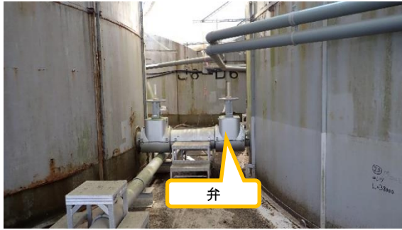
(写真 5) 連結管の状況
