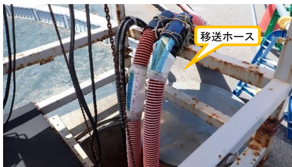
(写真 2 - 1) 移送ホースの設置状況 (K排水路からの汲み上げ)
