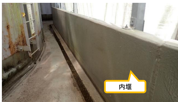
(写真 4) 内堰の状況
