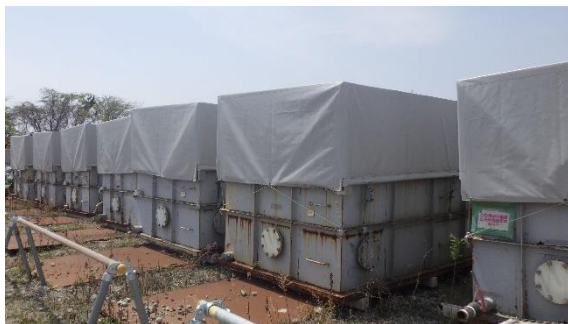
(写真2) ノッチタンクの仮置き状況
