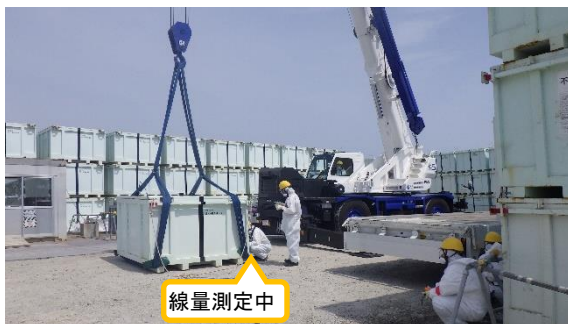
(写真5) コンテナ表面の線量測定状況
