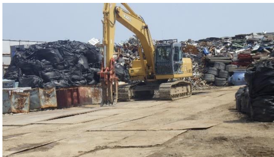
(写真 1 - 1) 不燃物の仮置き状況①
