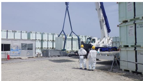
(写真4) コンテナ運搬作業の状況
