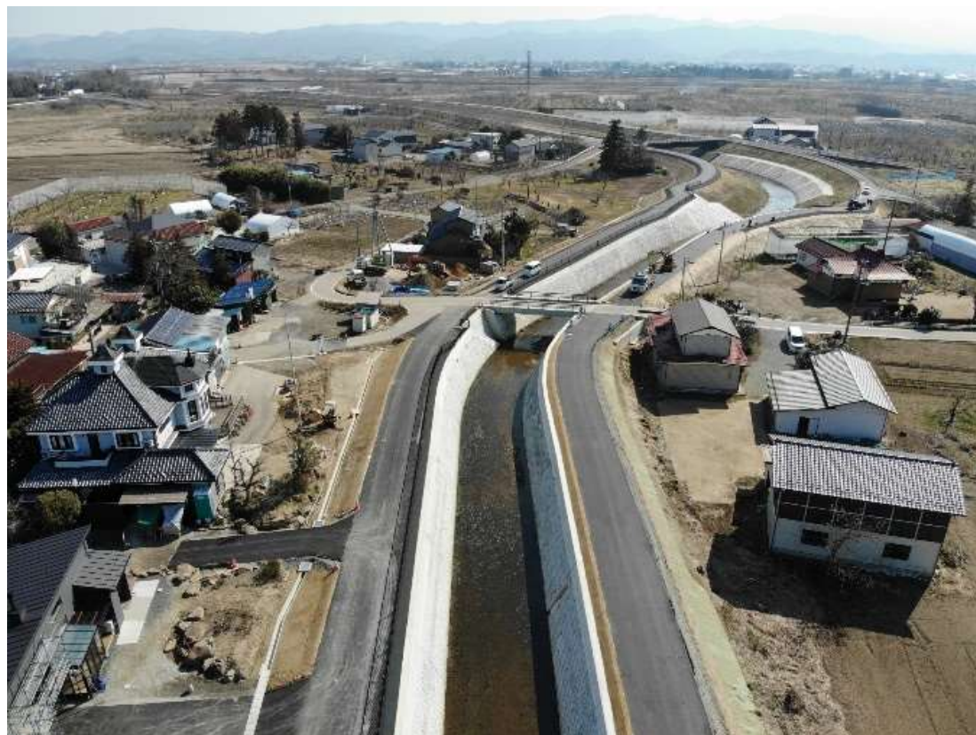
佐久間川河川海岸改良工事（桑折町）
