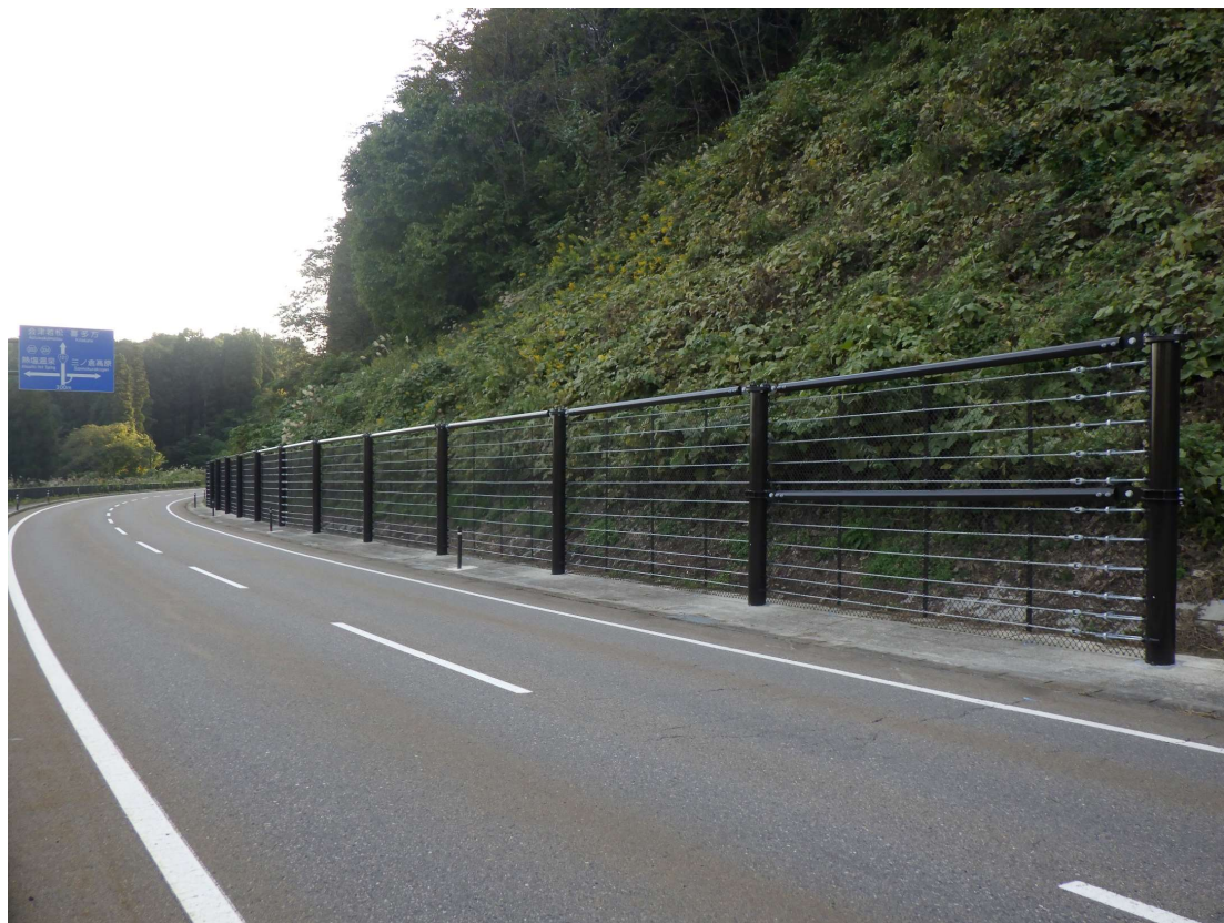
国道121号大峠落石防護柵工事（喜多方市）
