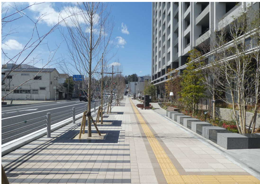
国道３９９号いわき駅前道路改良工事（いわき市）
