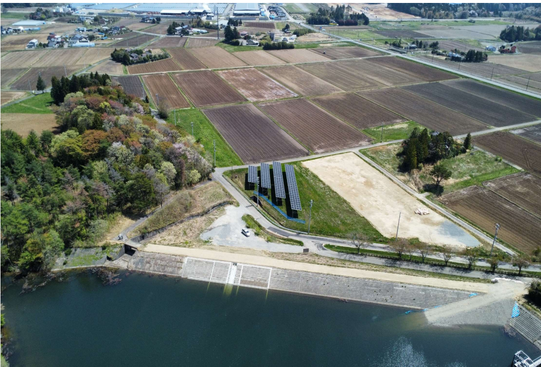
金ヶ森地区ため池工事（浪江町）
