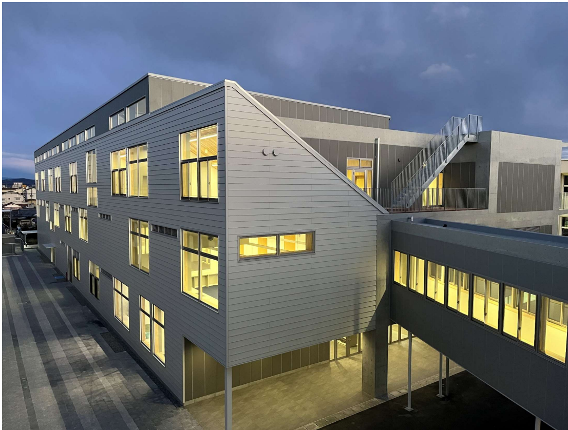
安積中高一貫校整備工事（郡山市）
