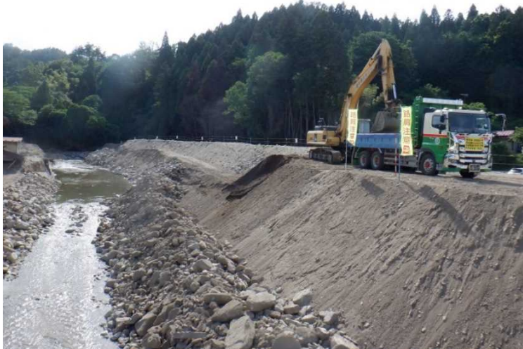
河道掘削の状況(河川)
