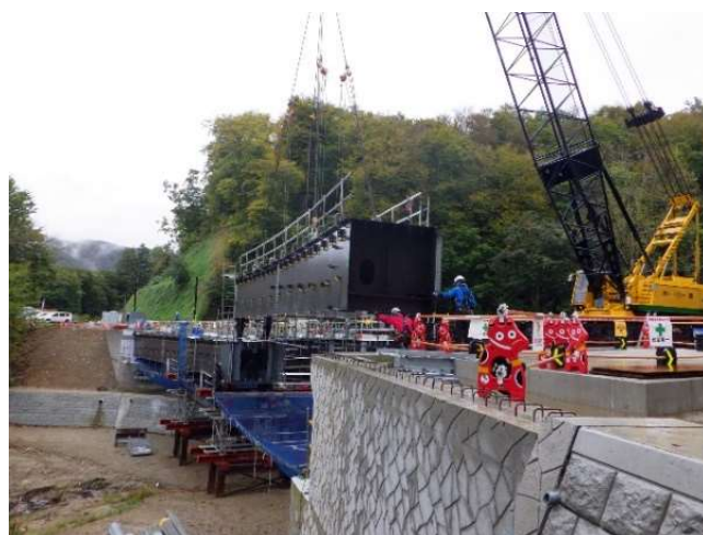
ひばら橋 桁架設状況 (R6.10月)
