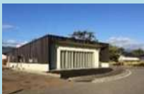
猪苗代水環境センター (猪苗代町)
