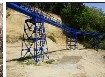
【復旧完了】 （新たに製作据付）
