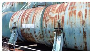
(写真2) タンクの腐食状況
