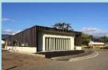
猪苗代水環境センター (猪苗代町)
