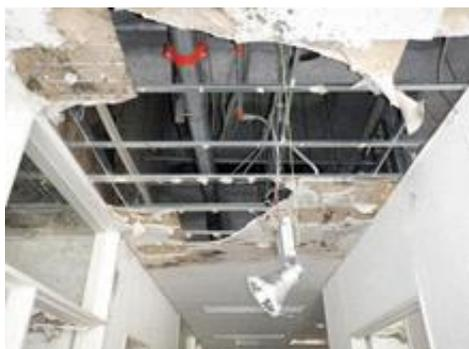
天井漏水跡、仕上材剥離
