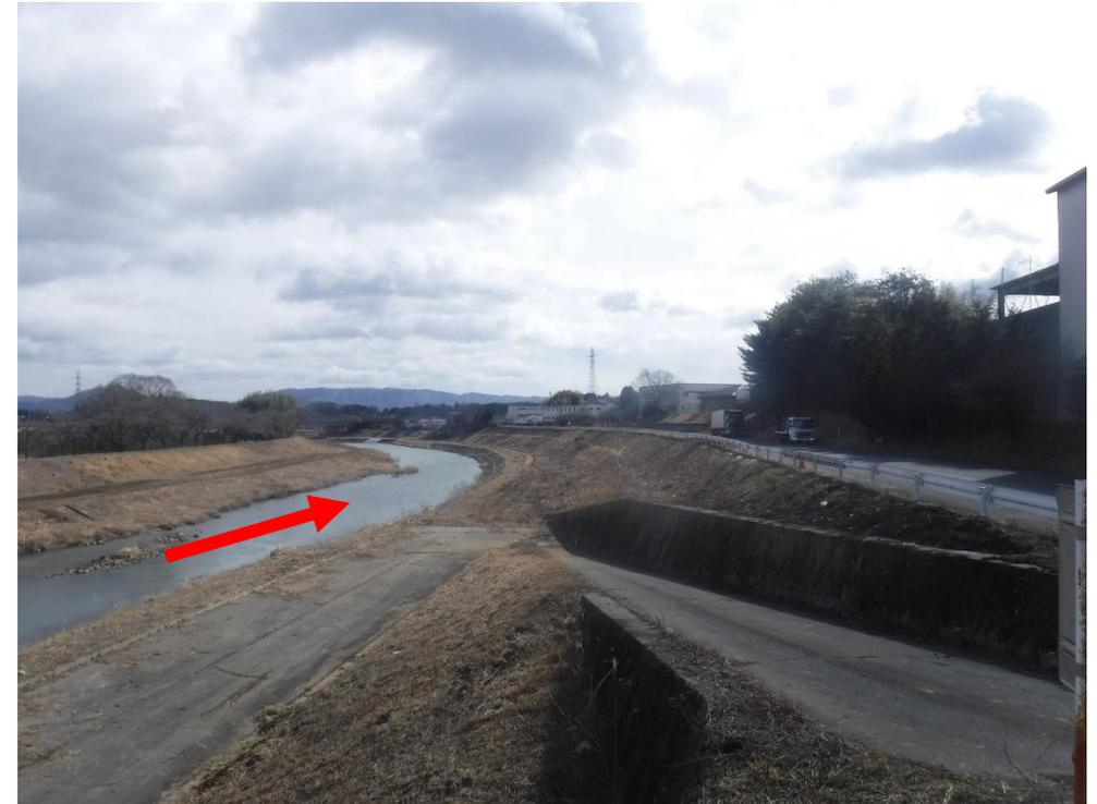
県では頻発化・激甚化する水災害に備え、雨水が河川を円滑に流れ下れるよう、河川内に繁茂した雑木の伐採及び河道掘削を進めています。
