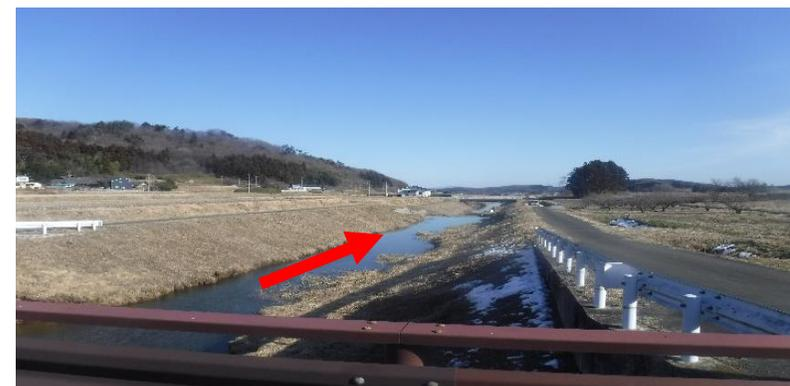
県では頻発化・激甚化する水災害に備え、雨水が河川を円滑に流れ下れるよう、河川内に繁茂した雑木の伐採及び河道掘削を進めています。
