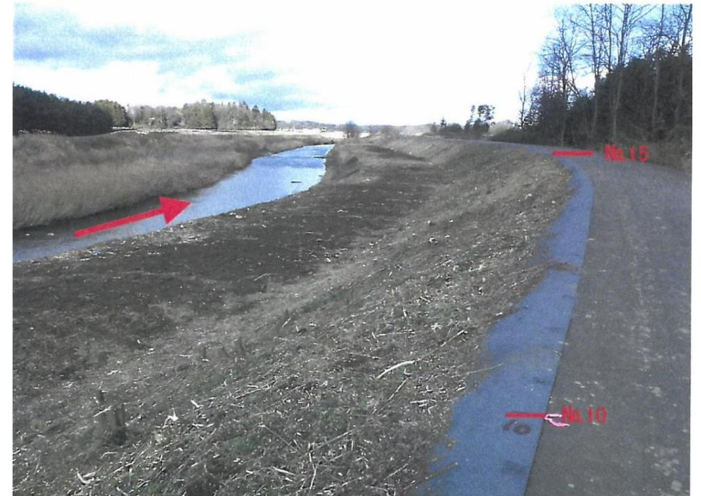
県では頻発化・激甚化する水災害に備え、雨水が河川を円滑に流れ下れるよう、河川内に繁茂した雑木の伐採及び河道掘削を進めています。
