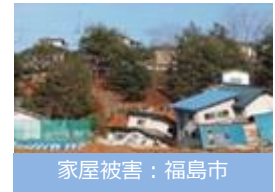
津波被害：浪江町
