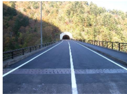
概要：路面の剥離が著しい橋梁の橋面舗装工の実施により快適に走れるようになりました。
