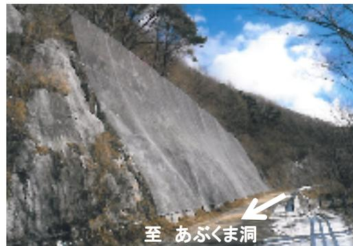
概要：落石があった箇所および恐れのある箇所に設置した落石防護網の補修により安全かつ安心して走れるようになりました。
