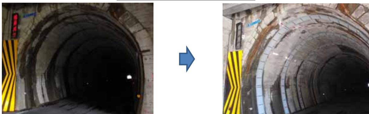
概要：トンネル壁面の漏水対策により水跳ねがなくなり安心して通れるようになりました。
