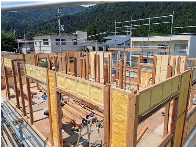
■再利用した壁パネル
