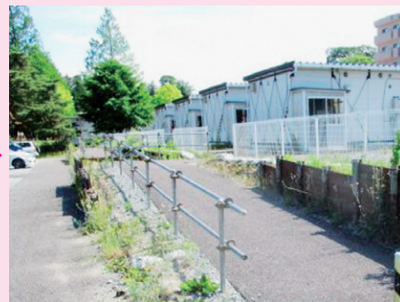
嵩上げ後(北側より撮影)
