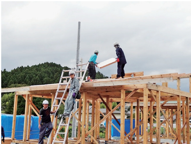
移設後の組立状況
