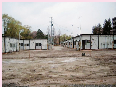
当初建設時(北側より撮影)
