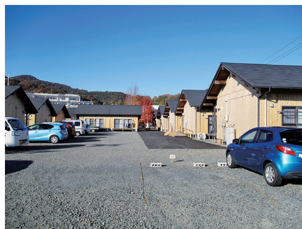
写真-8 【転用後】応急仮設住宅(総社市西地区)
