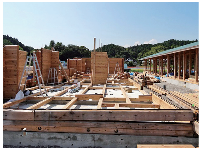
ログハウスの解体状況
