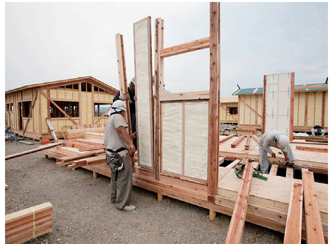
移設後の組立状況
