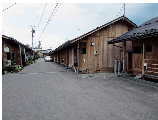
写真－５ 【転用前】応急仮設住宅(城北団地)
