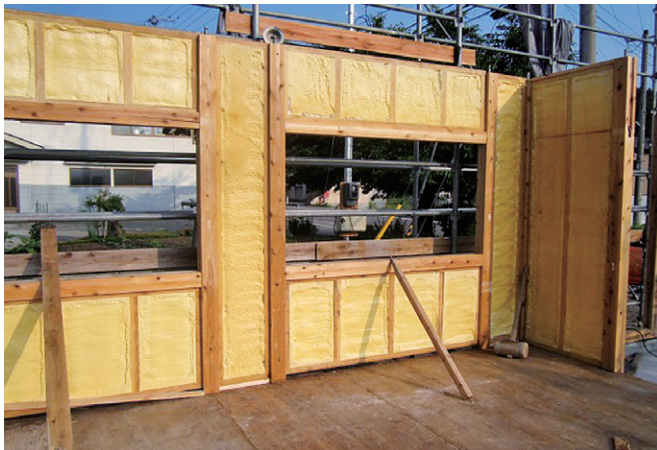
■再利用した壁パネル
