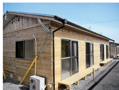
③住戸に縁側を設置
