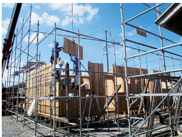
写真-7 【転用中】応急仮設住宅(総社市西地区)
