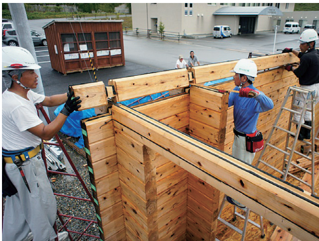
ログハウスの解体状況
