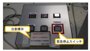
(写真1-3) 協力企業作業員が誤って押した 緊急停止スイッチ
