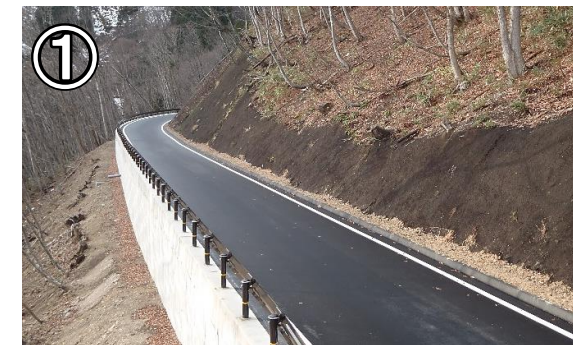
完成区間(柳津工区)
