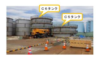
(写真4)C5タンクは4段目、3段目の側板が撤去。C6タンクには歩廊が設置
