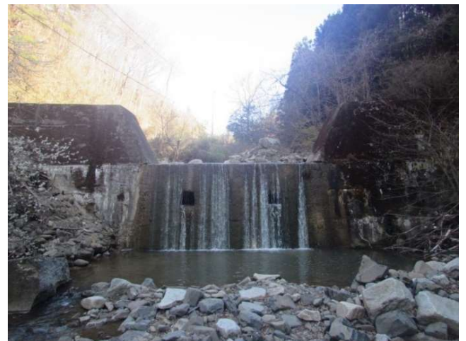
山舟生川砂防えん堤（梁川町）
