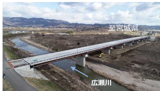
国道349号 梁川バイパス (伊達市梁川町)
