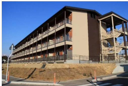
復興公営住宅 《北沢又団地（福島市）》 木造(CLT工法)3階建て(H31.2竣工)
