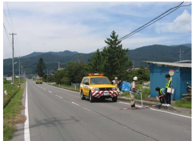
道路の異常を点検している様子
