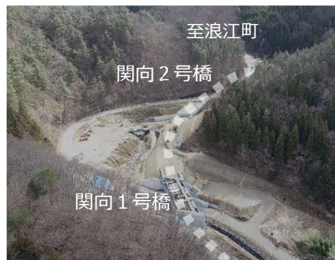
国道114号 山木屋1工区 (川俣町)
