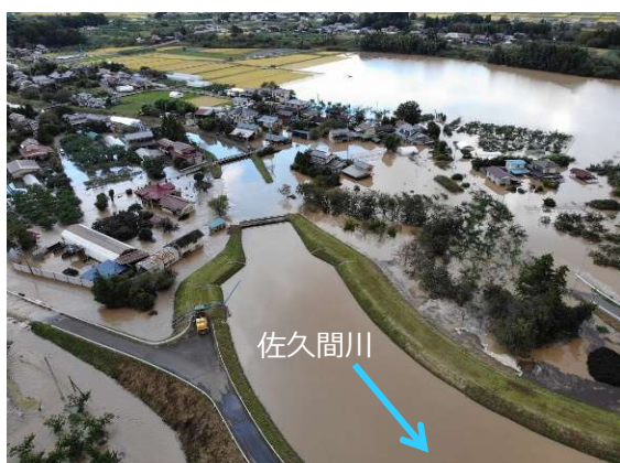
佐久間川（伊達郡桑折町） 被災状況
