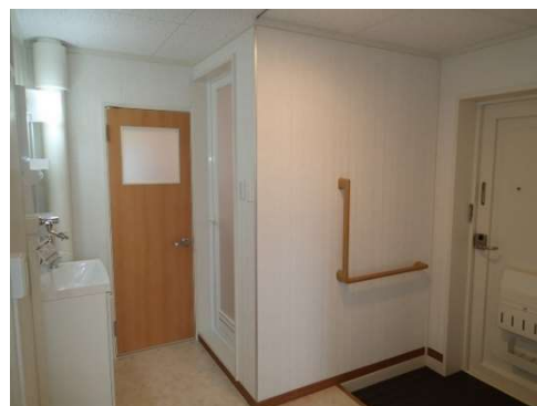
改修による手すりの設置等 《県営蓬萊団地（福島市）》
