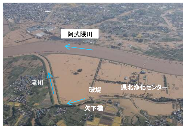
滝川（伊達郡国見町） 被災状況
