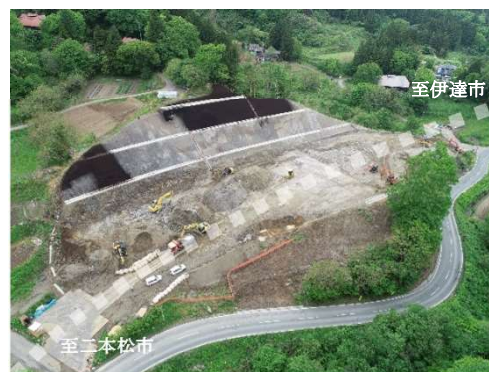
国道349号 大綱木1工区 (川俣町)
