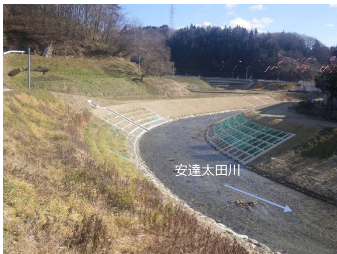
安達太田川（二本松市太田）開削護岸
