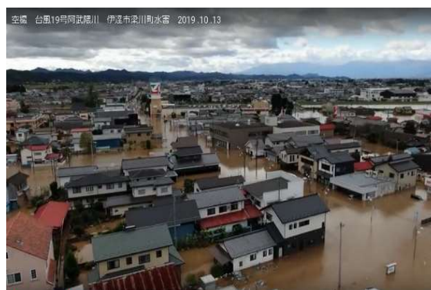
塩野川（伊達市梁川町） 被災状況
