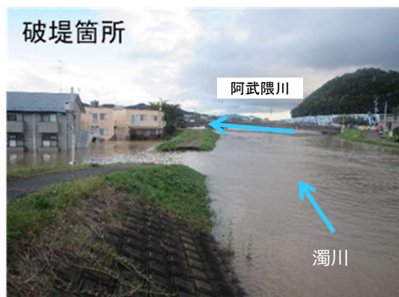
濁川（福島市郷野目） 被災状況
