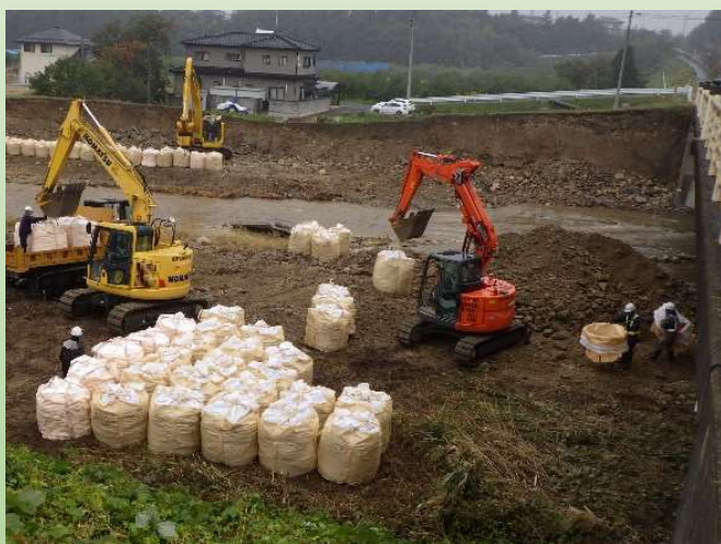
【「安らぎ」と「ゆとり」が持てる県民生活の確保】 台風19号における災害復旧 応急工事
