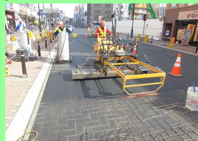
アスファルト舗装版を加熱し、表面を柔らかくしています。
