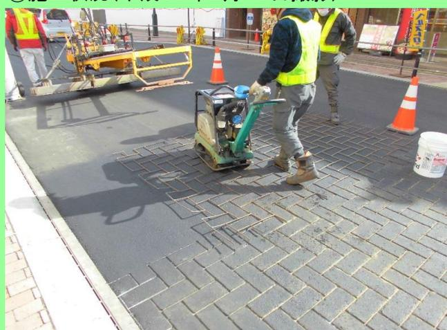
テンプレートを使用し、型押しを行っています。型押し完了後、着色を行います。
