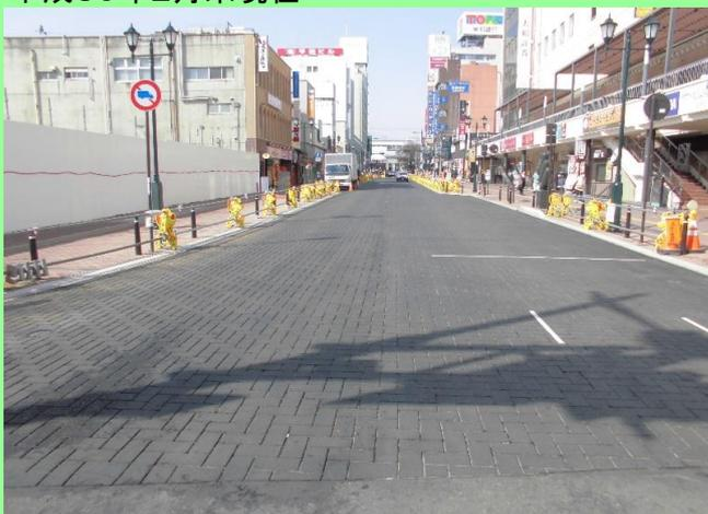
ストリートプリント(型押しアスファルト舗装)を行い、レンガ調の道路にします。
