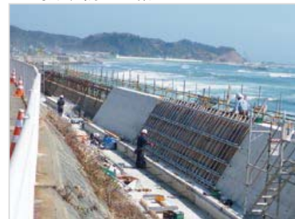
海岸堤防の整備(いわき市永崎地区)
