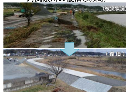
阿武隈川の復旧(矢吹町)
