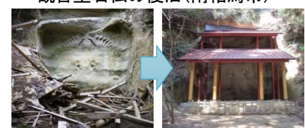
観音堂石仏の復旧(南相馬市)
