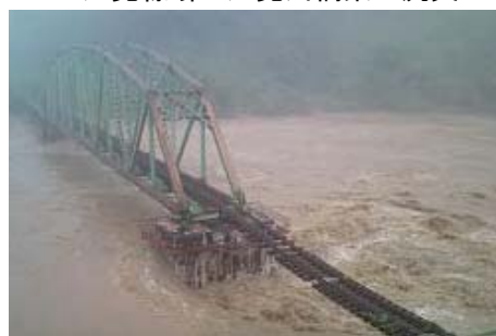
JR只見線 第5只見川橋梁の流失
