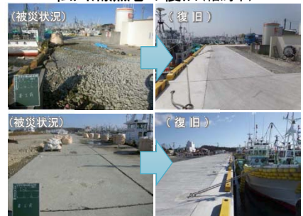
松川浦漁港の復旧(相馬市)
