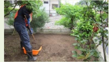
除染作業の様子
