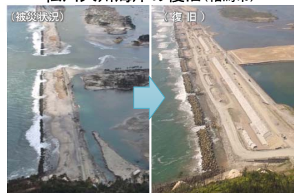
松川大州海岸の復旧(相馬市)
