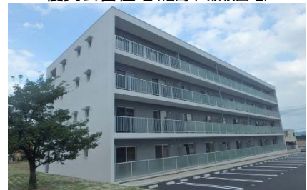
復興公営住宅（福島市 飯坂団地）
