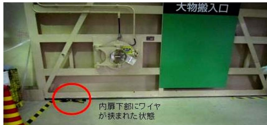
内扉開閉時は、内扉が約130ミリ上昇した後、壁から約15ミリ離れ、スライドして開閉する。スライド後、約130ミリ下降し、壁側に約15ミリ戻って開閉終了となる
